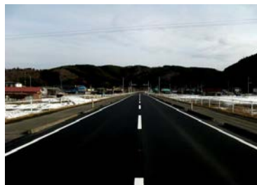
米川舗装補修工事 東北二チレキ(株)
