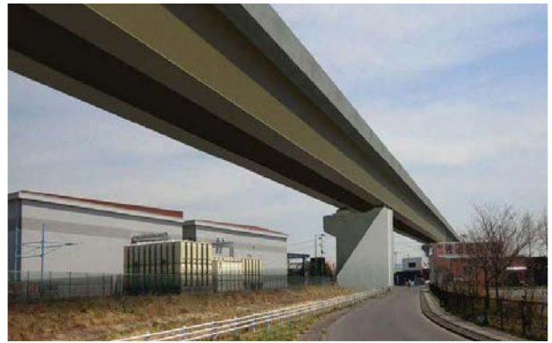
加賀野高架橋
