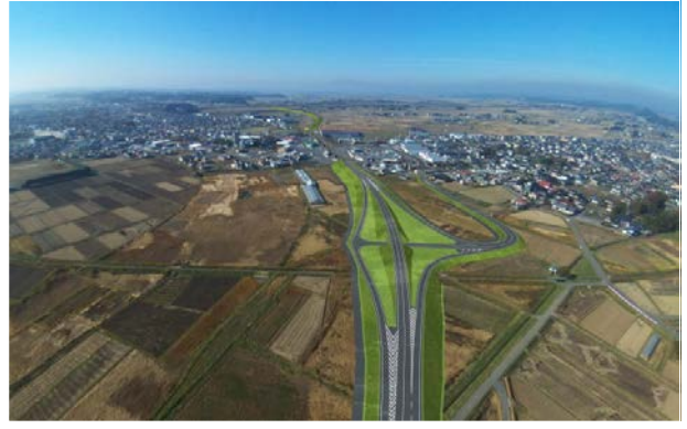
佐沼インターチェンジ 登米市迫町佐沼地内の国道346号との接続部
