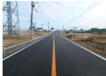
小金丁外舗装補修工事 日建工業(株)
