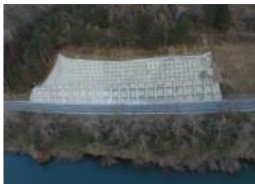
六反災害防除工事 陽光建設(株)
