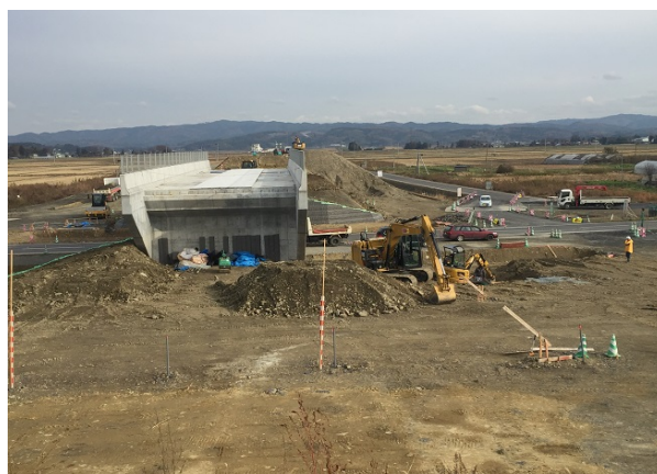
【そよかぜライン付近】 中田工区（4.7 km区間）の中間点となります 橋梁前後の盛土工事を行っています
