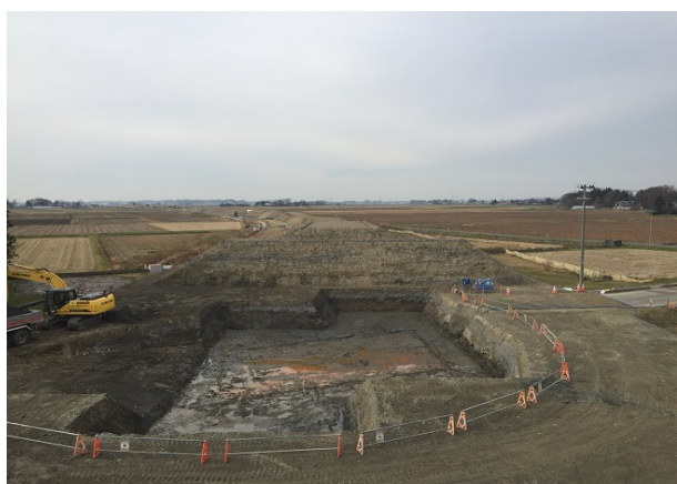
【県道石森登米線付近】 市道ボックス設置箇所 ボックスの床付け作業を行っています
