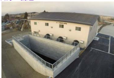
H26五ヶ村堀地区(かん排)-061号 五ヶ村堀排水機場工事 農村整備課 発注
