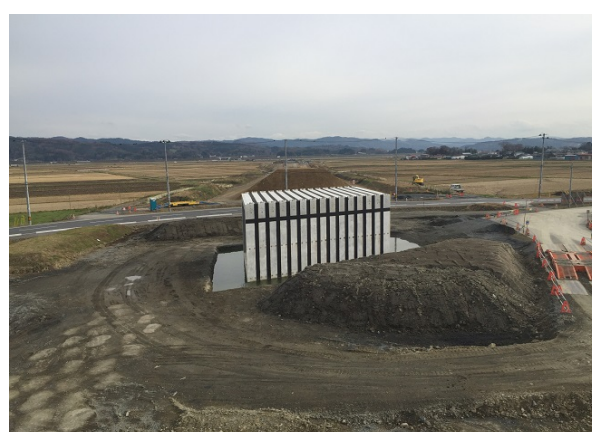
【県道石森登米線付近】 県道ボックスが完成しました これから県道の切り替え工事を行います
