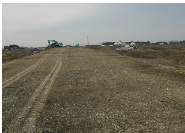
【終点部IC付近】 これから舗装工事に着手します
