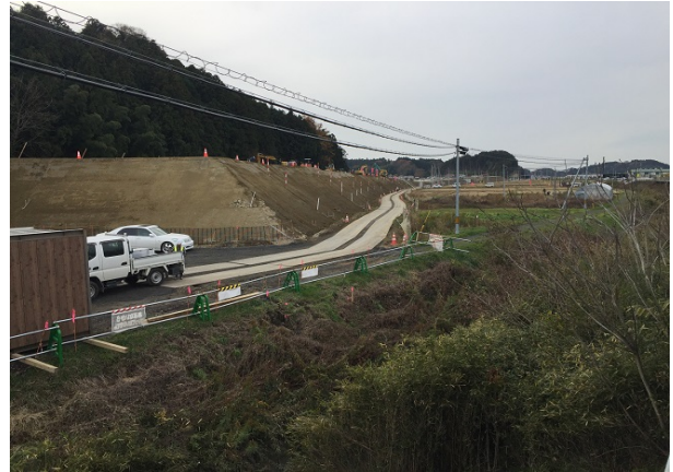
【紫雲山（迫町北方）付近】 盛土工事を行っています これから（仮）1号橋の橋台工事に着手します
