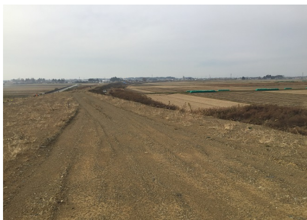
【そよかぜライン付近】 （仮）中田IC付近の盛土区間の状況です 中田工区の殆どが盛土構造となります
