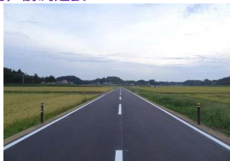
H27飯島地区(担い手)-002号 飯島地区区画整理付帯工事 東部地方振興事務所登米地域事務所 発注
