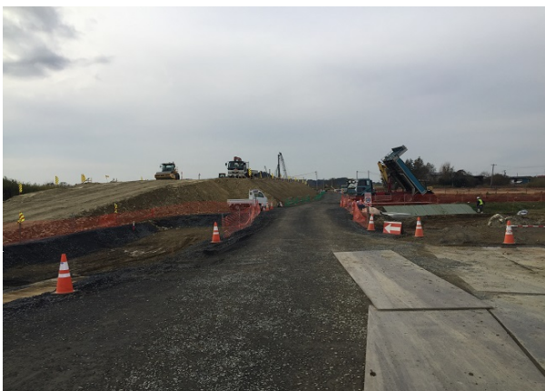
【迫川左岸（中田町石森）付近】 盛土工事を行っています
