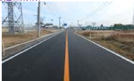
平成28年度県舗補05001-A03号 小金丁外舗装補修工事
