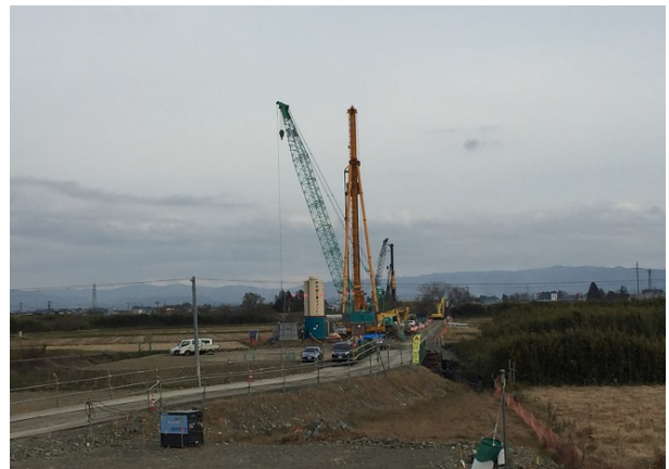
【迫川右岸（迫町佐沼）付近】 （仮）1号橋の橋脚基礎工事を行っています これから橋脚本体に着手します
