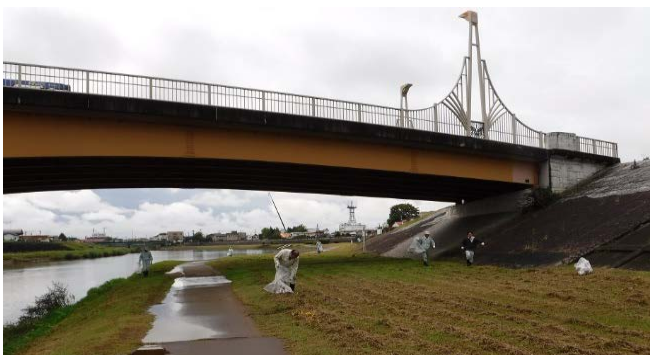
迫川右岸（鹿ヶ城大橋）付近での清掃活動
