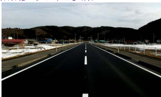
平成28年度社道防安19-87-A01号 米川舗装補修工事
