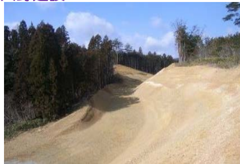
H28南三陸地区(復興基盤)-A81号 西戸川工区集落道路及び区画整理付帯工事 気仙沼地方振興事務所 発注
