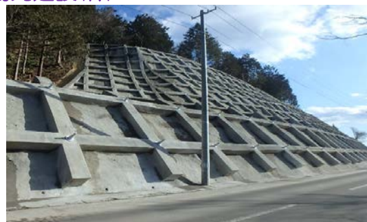
平成28年度社道復興防災12-504-A01号 六反災害防除工事
