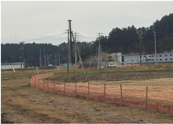
【起点部IC（迫町北方）付近】 地盤改良工事を行っています
