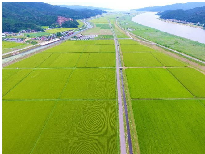
▲事業により整備された飯野川地区
