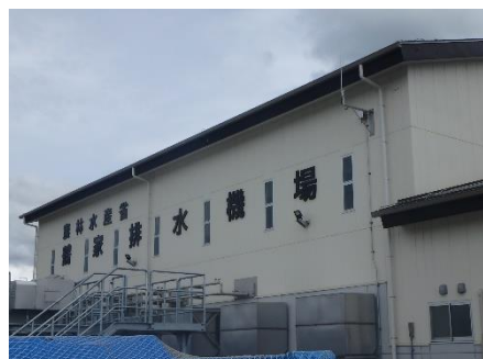
▲当事業により整備された鶴家排水機場
