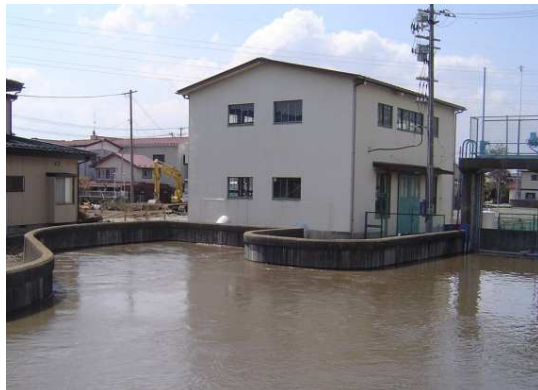
▲ 被災直後の蛇田排水機場
