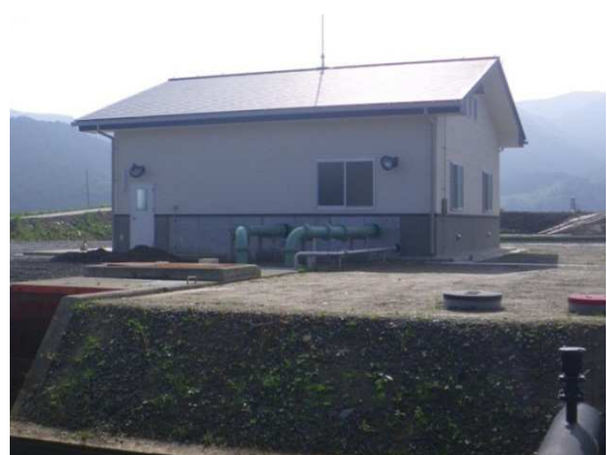
▲ 平成25年9月 復旧完了
