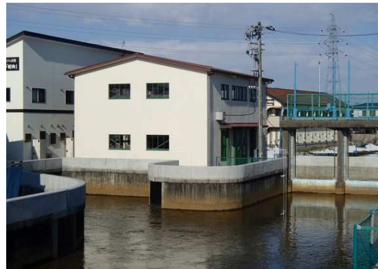
▲ 平成26年1月 復旧工事完了
