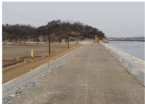
▲ 平成26年3月 復旧間近の海岸堤防
