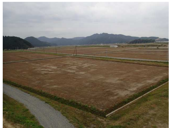
▲ 平成25年9月 針岡工区 復旧工事完了
