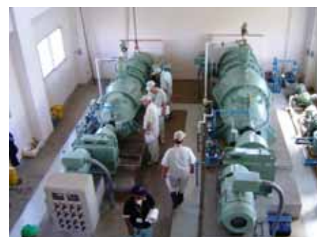
現地調査の様子
