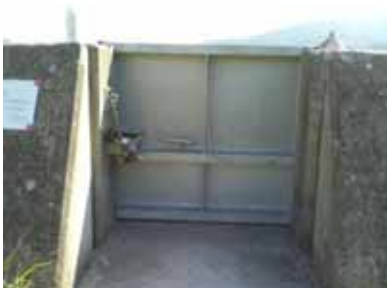
閉鎖した水門の様子
