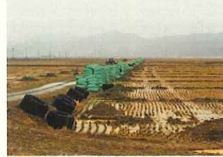
暗渠追加工事
