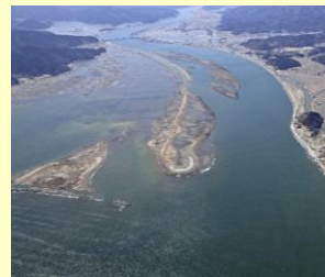
震災後(平成25年4月)
