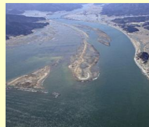
震災後(平成23年4月)
