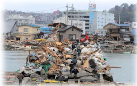
【津波被災直後(東内海橋)】
