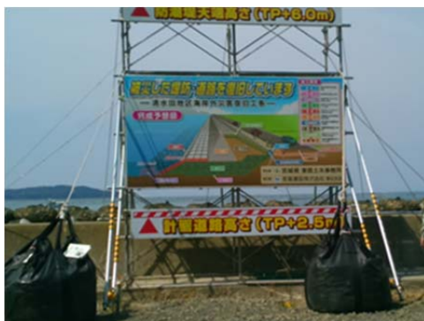
【清水田海岸災害復旧工事】
