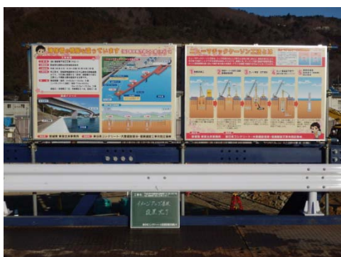
【浦宿道路改良工事】
