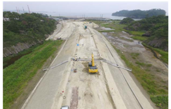
【(主)奥松島松島公園線 宮戸道路改良】
