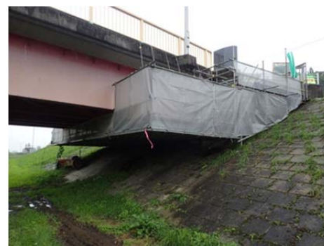
【及川橋耐震補強】
