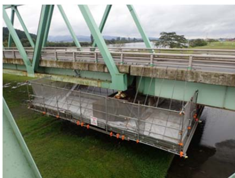
【神取橋耐震補強】
