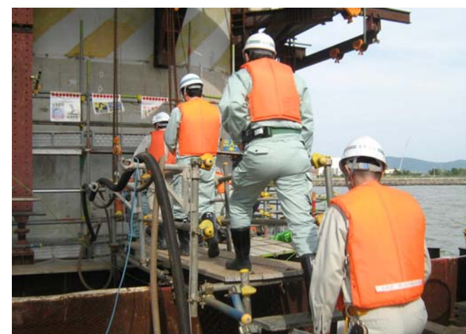
台船より鋼板内部へ
