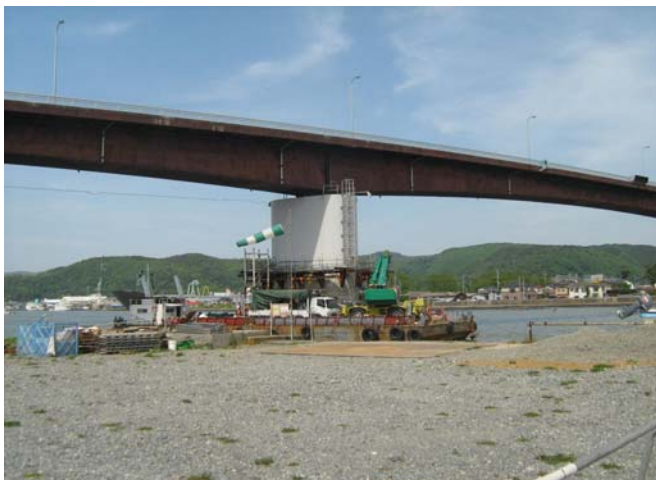
見学会当日の現場の様子
