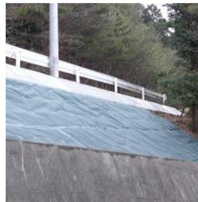
※今回の試験施工では、防草シートメーカーからの資材提供を受けたため、法面下部までシートを施工した。
