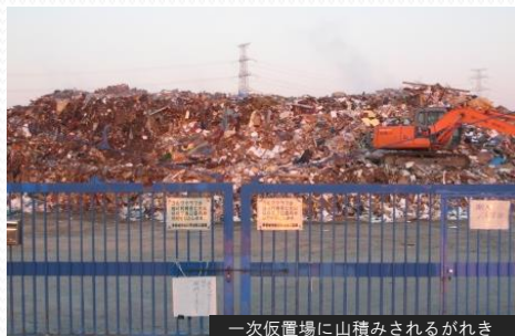
一次仮置場に山積みされるがれき
