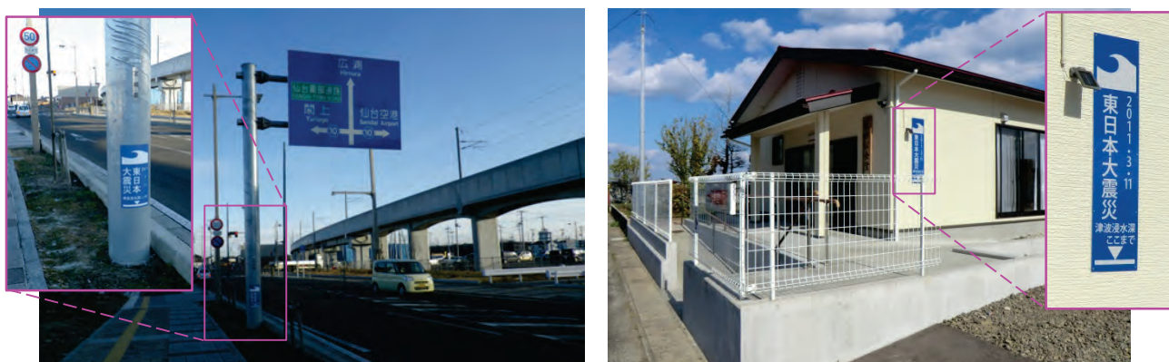
図 5-3 津波浸水表示板の設置状況
