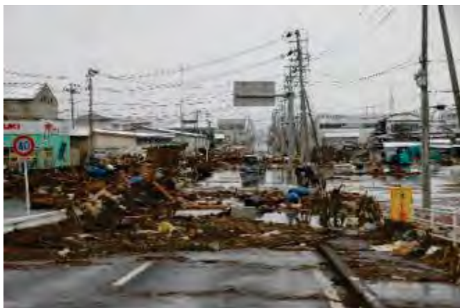
図 2-47 冠水により通行不能となった道路
