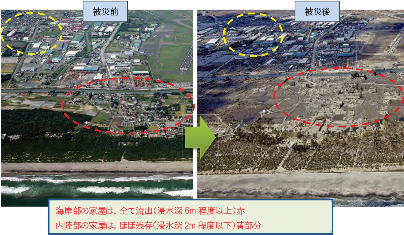
図 2-32 仙台湾沿岸の家屋流出状況
