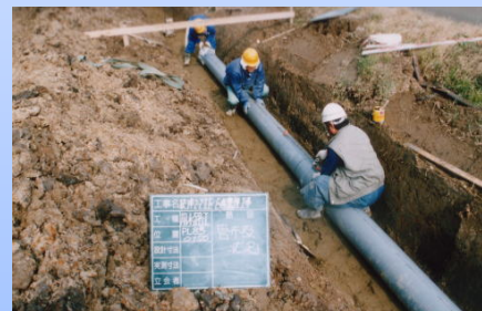
農業用水路の設置
