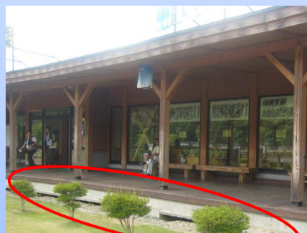
沈下した基礎部の補修、補強
