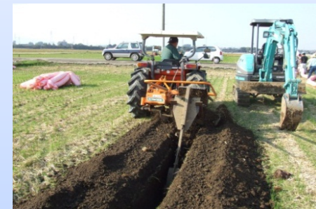
暗渠排水の設置
