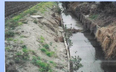
老朽水路の改修
