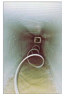
管渠耐震化工法(更生工法の採用)
