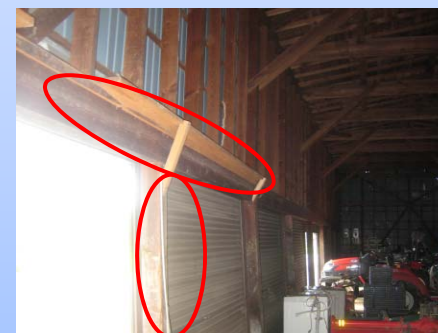
柱・梁の歪みの補修、補強
