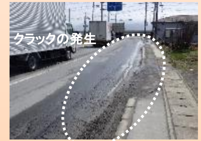
沿岸部の舗装劣化状況
