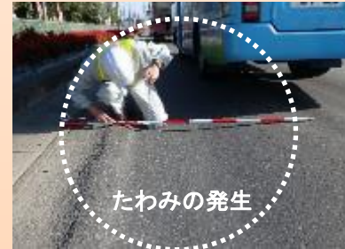
沿岸部の舗装劣化状況
