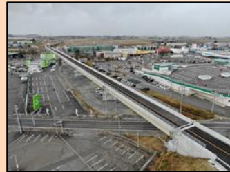
県北高速幹線道路 Ⅲ期(佐沼工区)
