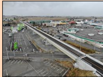
県北高速幹線道路 Ⅲ期(佐沼工区)
