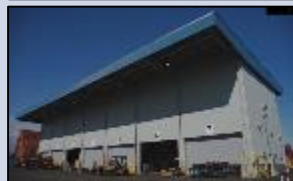
高砂コンテナターミナル トラックゲート(上)・多目的置場(下)
