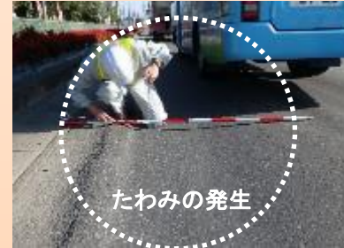
沿岸部の舗装劣化状況
