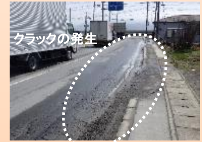
沿岸部の舗装劣化状況
