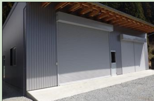
グループ補助金を活用して 整備された木材保管庫 (気仙沼市)
