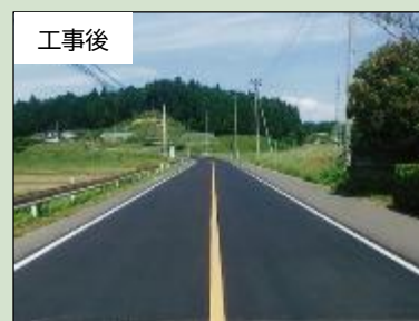
内陸部の舗装補修事例 (国)113号
