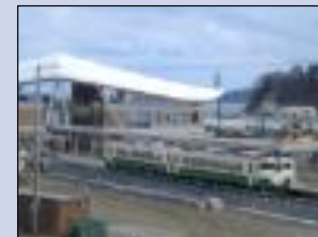
運行が再開された石巻線 (女川駅)
