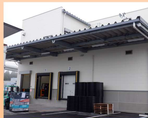
グループ補助金を活用して整備された水産加工施設(気仙沼市)
