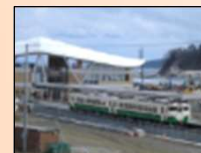
運行が再開された石巻線(女川駅)
