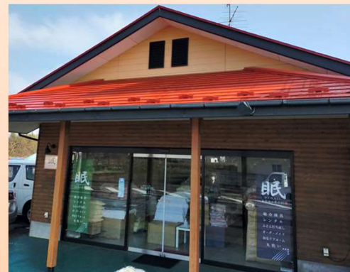
グループ補助金を活用して整備された店舗(東松島市)
