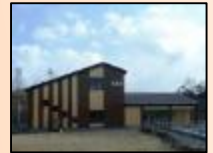
野蒜駅(新駅舎)
