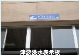
津波浸水表示板
