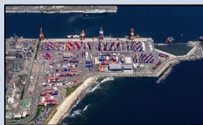
仙台塩釜港(仙台港区)高砂コンテナターミナル
