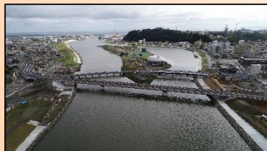
開通箇所の状況 (内海橋)
