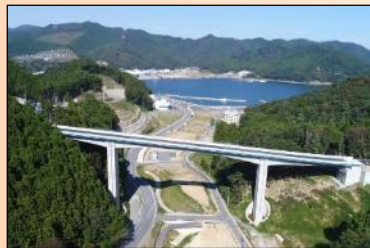
開通箇所の状況 (小乗大橋)
