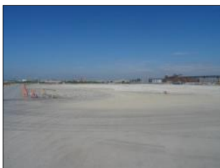
焼却炉解体後の状況 (石巻ブロック)
