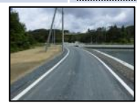
復旧した林道 日向貝線 (気仙沼市)
