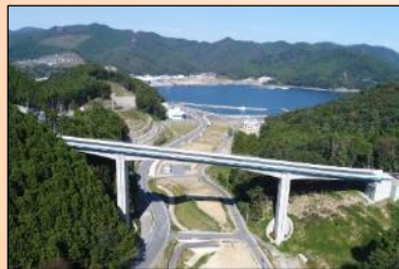
開通箇所の状況 (小乗大橋)
