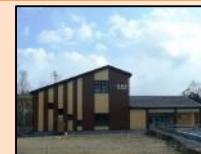
野蒜駅(新駅舎)
