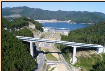
開通箇所の状況 (小乗大橋)
