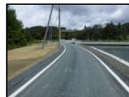
復旧した林道 日向貝線 (気仙沼市)
