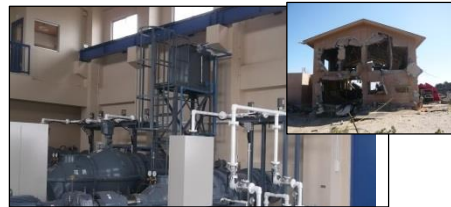
復旧した花笠第2排水機場 (山元町)
