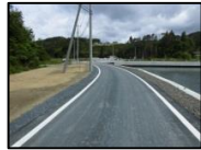
復旧した林道 日向貝線 (気仙沼市)
