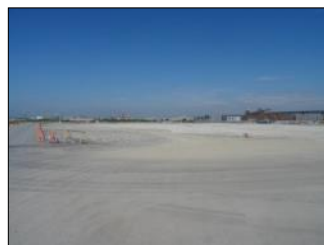
焼却炉解体後の状況 (石巻ブロック)
