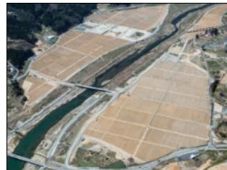
気仙沼処理区小泉地区の原状 復旧状況(気仙沼ブロック)
