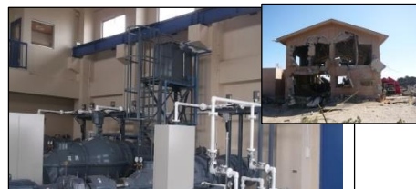
復旧した花笠第2排水機場 (山元町)
