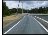
復旧した林道 日向貝線 (気仙沼市)
