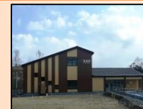
野蒜駅(新駅舎)
