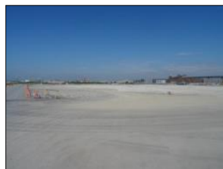
焼却炉解体後の状況 (石巻ブロック)
