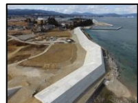
復旧した防潮堤 (気仙沼市崎野)
