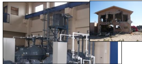
復旧した花笠第2排水機場 (山元町)
