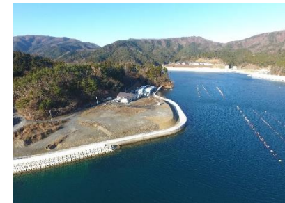
雄勝港唐桑地区海岸 (石巻市)
