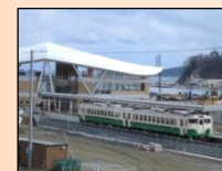
運行が再開された石巻線 (女川駅)
