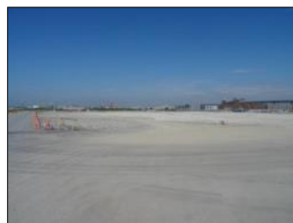
焼却炉解体後の状況 (石巻ブロック)
