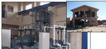
復旧した花笠第2排水機場 (山元町)
