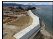
復旧した防潮堤 (気仙沼市崎野)
