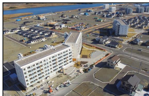
災害公営住宅整備状況 (名取市関上地区)
