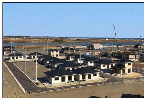
災害公営住宅整備状況 (名取市関上地区)
