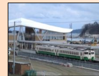
運行が再開された石巻線(女川駅)
