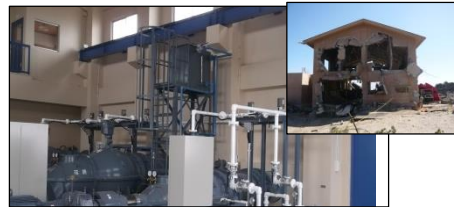
復旧した花笠第2排水機場 (山元町)
