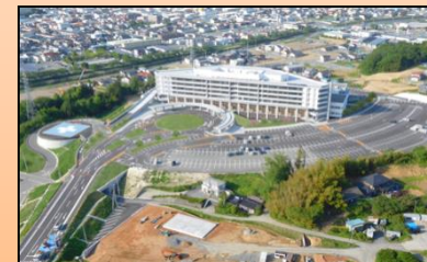
気仙沼市立病院 新築移転 (平成29年10月 気仙沼市)
