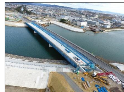
(一) 石巻工業港矢本線(定川大橋) (石巻市・東松島市)
