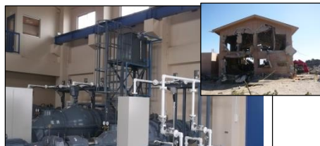
復旧した花笠第2排水機場 (山元町)
