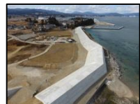
復旧した防潮堤 (気仙沼市崎野)
