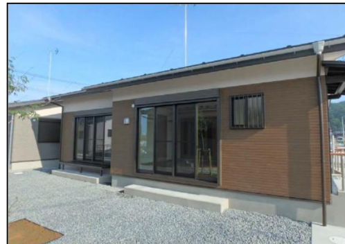
災害公営住宅整備状況 (石巻市河北地区)
