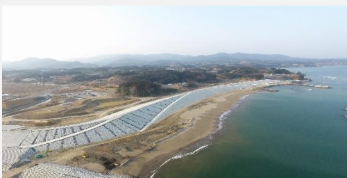
※防潮堤完成 引き続き、背後の盛土及び離岸堤の整備を進めています
