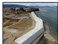
復旧した防潮堤 (気仙沼市崎野)
