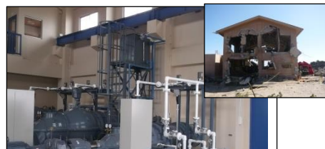
復旧した花笠第2排水機場 (山元町)
