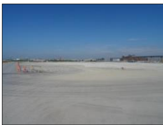
焼却炉解体後の状況 (石巻ブロック)
