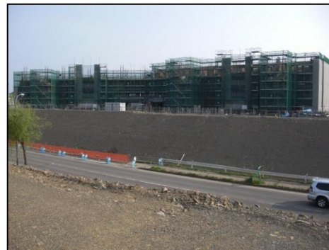
災害公営住宅整備状況 (名取市閑上地区)
