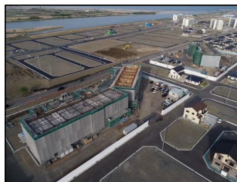
災害公営住宅整備状況 (名取市閑上地区)
