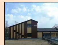
野蒜駅(新駅舎)
