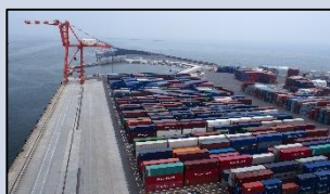
仙台塩釜港(仙台港区) 高砂コンテナターミナル
