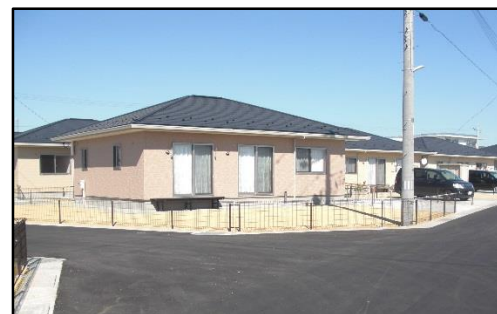
災害公営住宅整備状況 (名取市閑上地区)
