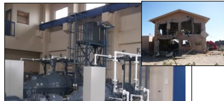
復旧した花笠第2排水機場 (山元町)
