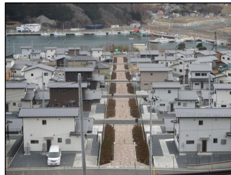
災害公営住宅整備状況 (女川町宮ヶ崎地区)
