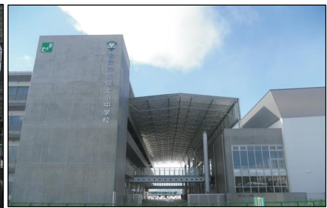
【平成30年2月28日】 名取市関上小中学校新校舎完成（4月開校）
