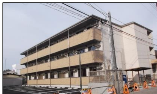
災害公営住宅整備状況 (石巻市大橋地区)
