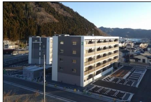
災害公営住宅整備状況 (女川町荒立・大道③地区)
