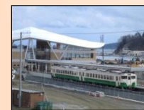
運行が再開された石巻線(女川駅)
