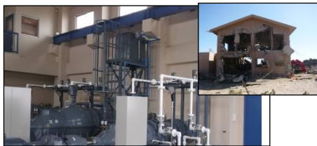
復旧した花笠第2排水機場 (山元町)
