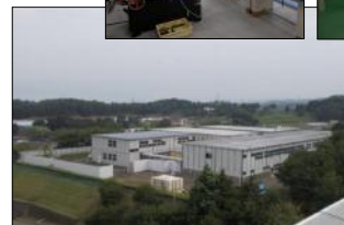
仮設校舎と仮設実習棟機械工作室・農産加工室 (宮城県農業高等学校)
