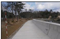
復旧した防潮護岸 (東松島市宮戸)
