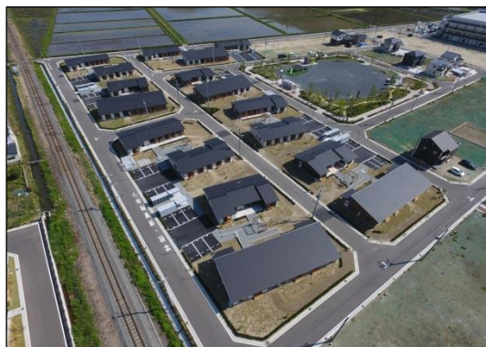
災害公営住宅整備状況 (石巻市新渡波地区(D街区))
