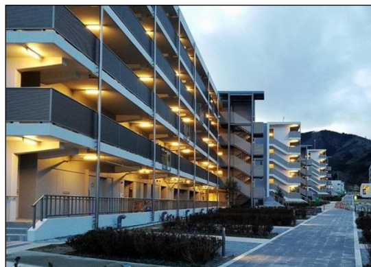
災害公営住宅整備状況 (女川町女川駅北地区)
