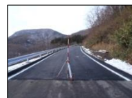
復旧した林道 高倉線(大和町)
