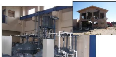
復旧した花笠第2排水機場(山元町)
