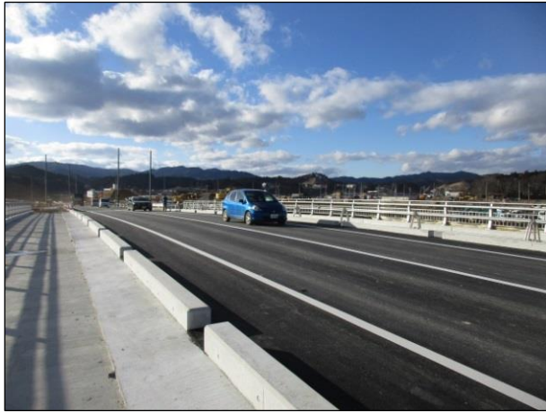
開通した県道清水浜志津川港線(南三陸町)
