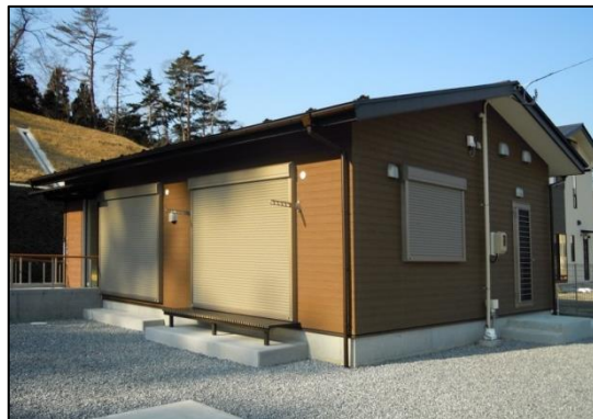
災害公営住宅整備状況 (石巻市唐桑地区)
