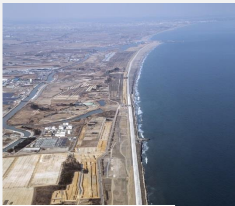
名取市~岩沼市 名取海岸・岩沼海岸【国施工】(完成) 建設
