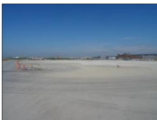
焼却炉解体後の状況 (石巻ブロック)
