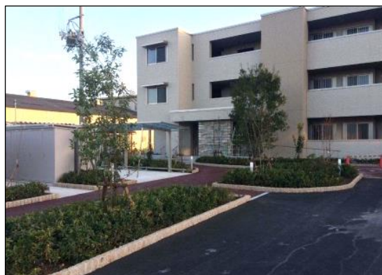
災害公営住宅整備状況(石巻市大街道東二丁目地区)
