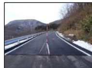
復旧した林道 高倉線(大和町)
