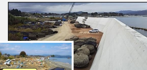
震災時 堤防本体工事を施工中です。
