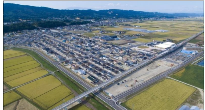
まちびらきした「つばめの杜地区」(山元町)
