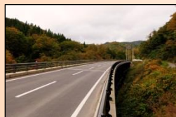
完成状況(宇津野1号栈道工)
