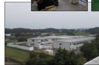
仮設校舎と仮設実習棟機械工作室・農産加工室 (宮城県農業高等学校)
