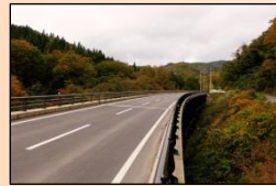
完成状況(宇津野1号栈道工)
