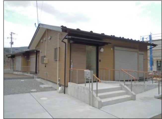
災害公営住宅整備状況 (石巻市雄勝中心部船戸地区)
