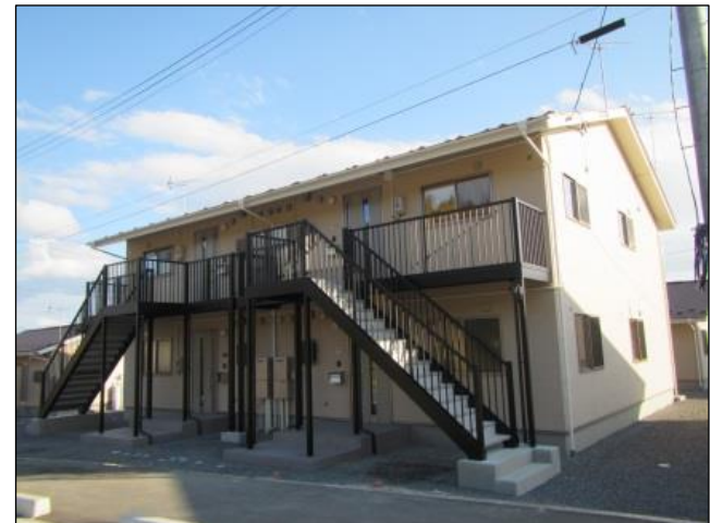
災害公営住宅整備状況 (気仙沼市面瀬地区)
