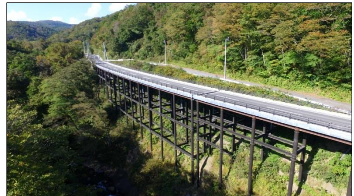
通年通行化された国道347号(加美町)
