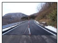
復旧した林道 高倉線(大和町)
