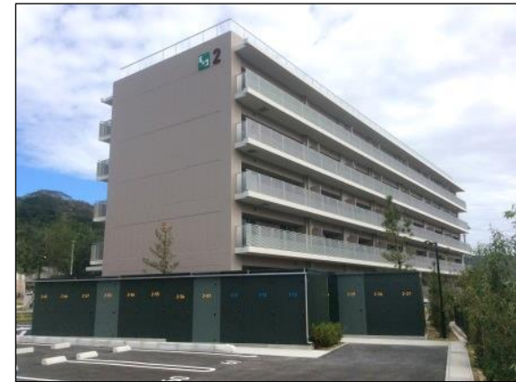
災害公営住宅整備状況 (石巻市新門脇地区(東街区))
