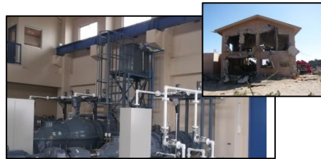
復旧した花笠第2排水機場(山元町)
