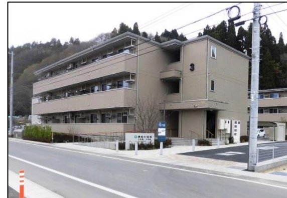
災害公営住宅整備状況(気仙沼市切通地区(B工区))
