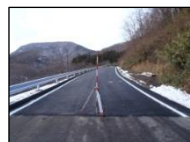
復旧した林道 高倉線(大和町)
