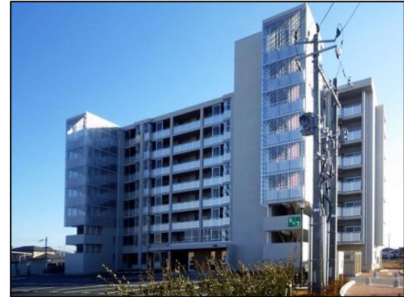
災害公営住宅整備状況(石巻市湊筒場地区)
