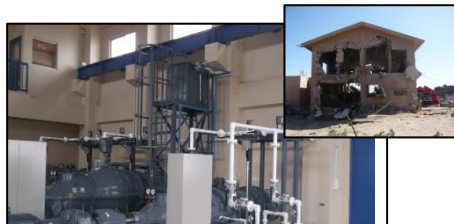
復旧した花笠第2排水機場 (山元町)
