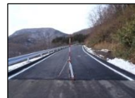
復旧した林道 高倉線(大和町)
