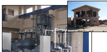
復旧した花笠第2排水機場 (山元町)
