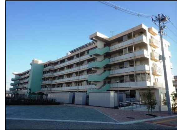
災害公営住宅整備状況(石巻市新蛇田南地区A街区)
