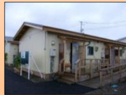
プレハブ仮設住宅(名取市)
