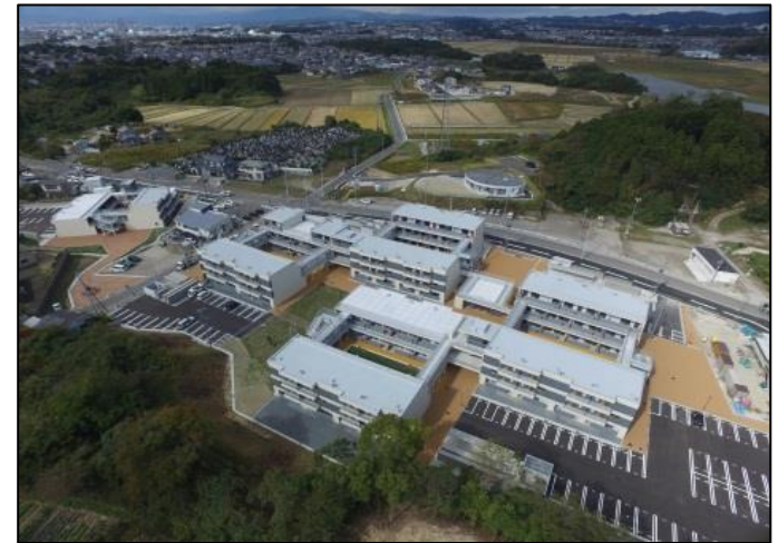
災害公営住宅整備状況(七ヶ浜町菖蒲田浜地区)
