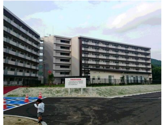
災害公営住宅整備状況 (仙台市落合地区)
