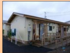
プレハブ仮設住宅(名取市)
