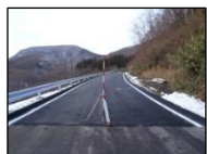
復旧した林道 高倉線(大和町)
