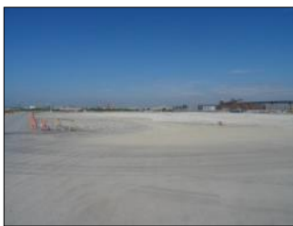
焼却炉解体後の状況 (石巻ブロック)
