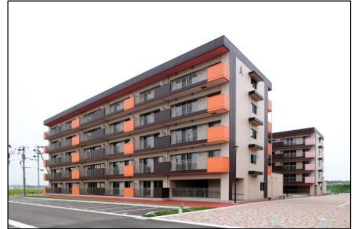
災害公営住宅整備状況 (石巻市新蛇田地区C街区)
