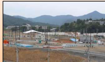
女川(中心部)地区整備事業(女川町)
