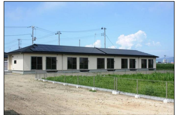
災害公営住宅整備状況(太陽光発電システム導入住宅) (東松島市赤井地区)
