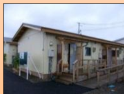
プレハブ仮設住宅(名取市)
