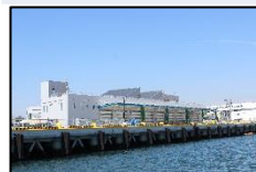
復旧が進められている 塩釜市魚市場
