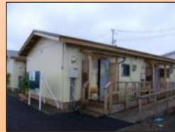
プレハブ仮設住宅(名取市)
