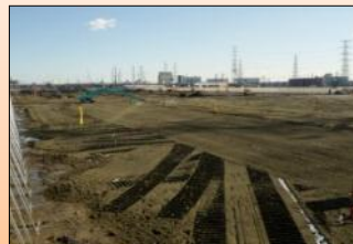
八幡地区工事状況 (多賀城市)
