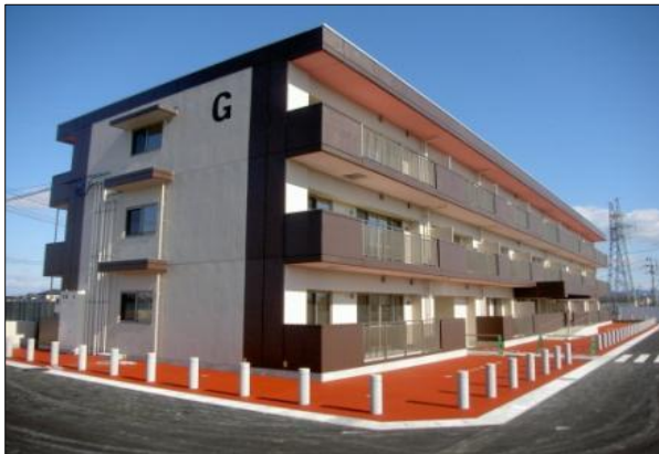
災害公営住宅整備状況 (石巻市新蛇田地区A1街区)
