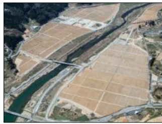
気仙沼処理区小泉地区の原状 復旧状況(気仙沼ブロック)
