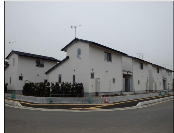
災害公営住宅整備状況 (岩沼市玉浦西地区)
