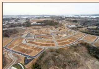
花瀨浜笹山地区造成工事状況 (七ヶ浜町)
