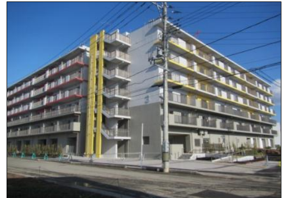
災害公営住宅整備状況 (気仙沼市南郷地区)
