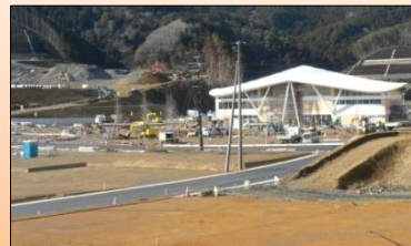
中心部地区工事状況 (女川町)
