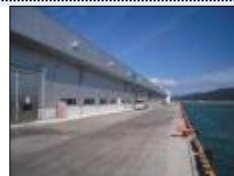
復旧工事が進められている 石巻魚市場
