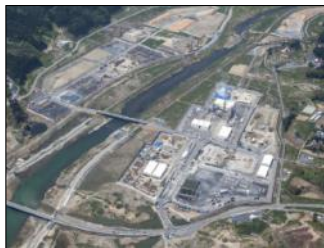
気仙沼処理区小泉地区の稼働時 (気仙沼ブロック)
