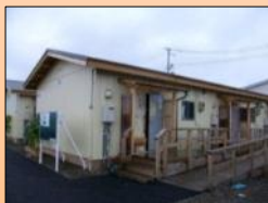
プレハブ仮設住宅(名取市)
