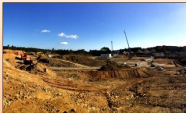
伊里前地区造成工事状況 (南三陸町)
