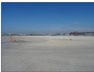
焼却炉解体後の状況 (石巻ブロック)
