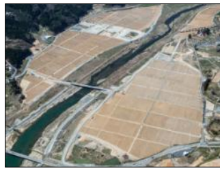
気仙沼処理区小泉地区の原状 復旧状況(気仙沼ブロック)
