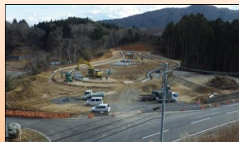
鮫浦地区 造成工事状況 (石巻市)
