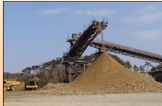
野蒜北部丘陵地区 掘削残土搬出状況 (東松島市)
