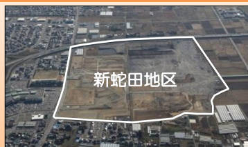
新蛇田地区 造成工事状況 (石巻市)
