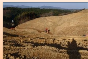
小泉地区 造成工事状況 (気仙沼市)
