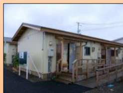
プレハブ仮設住宅(名取市)
