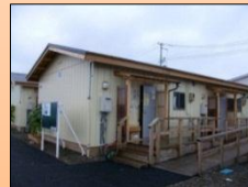
プレハブ仮設住宅(名取市)
