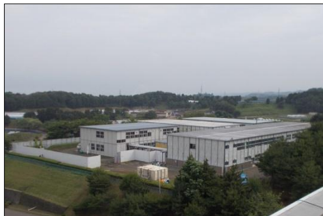
仮設校舎 (宮城県農業高等学校)
