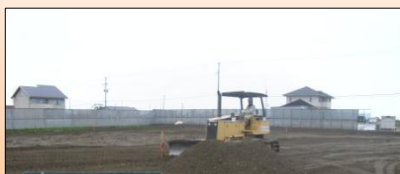
< 防災集団移転促進事業 > 荒浜中野地区盛土工事状況(亶理町)
